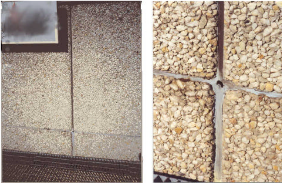
Bild av fog vid gallerdurk och detalj av fog.
